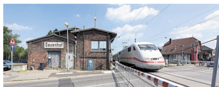
Und heute: Am verlassenen Bahnhofsgelände von 1847 prangt das Schild „Dauenhof“, der rechte Anbau – das Stellwerk – kam später dazu.
